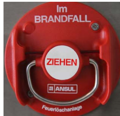
Handauslösung, zur manuellen Aktivierung des Löschanlagen.
